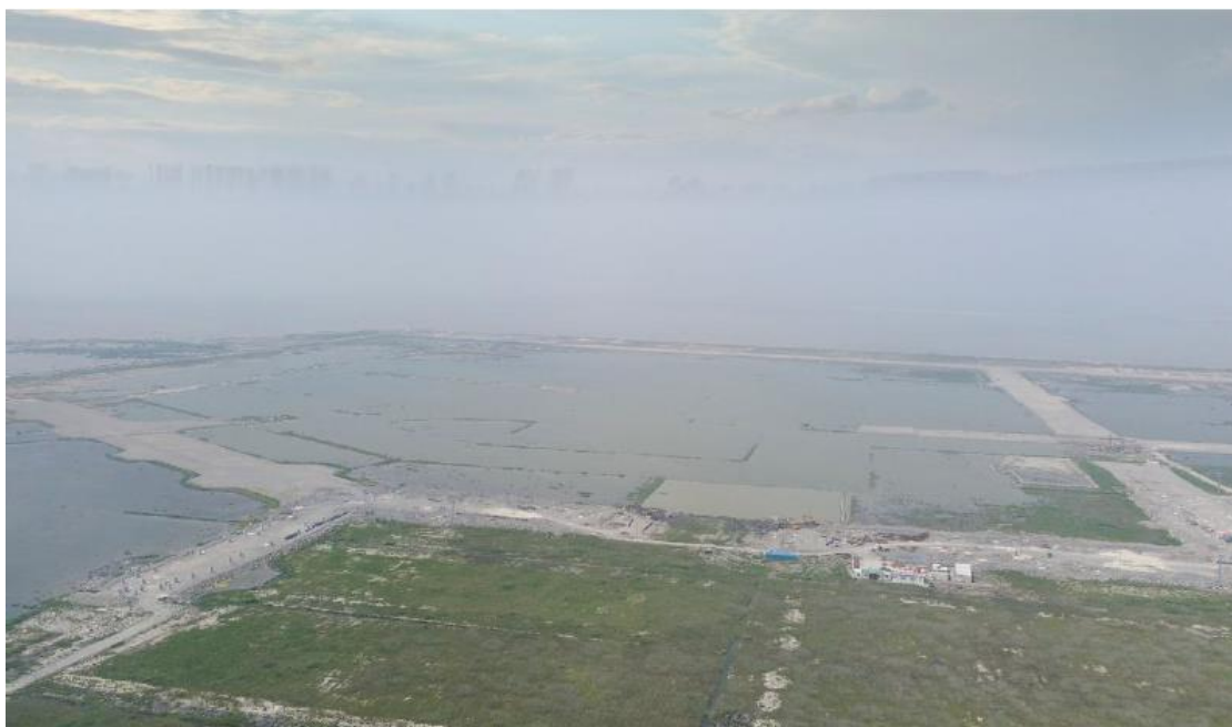
图 3.1-4c 浅滩一期工程区现状照片（3）
