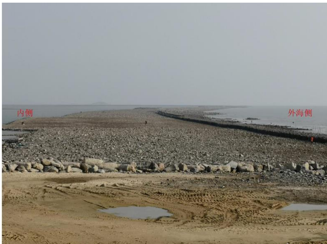
图 3.1-5d 浅滩二期（南堤）促淤堤现状照片（7，低潮位）
